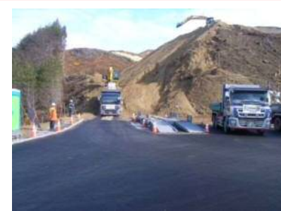
⑦施工：樋下建設
