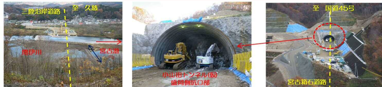
④施工：前田建設工業
