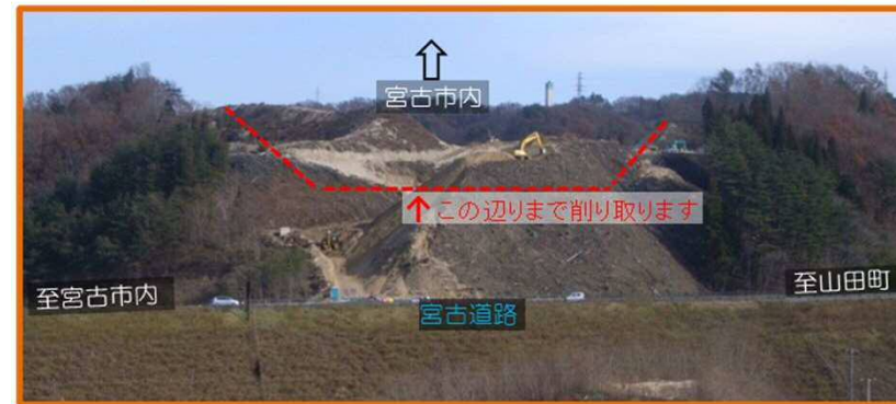
宮古道路に工事用車両出入り口を取付けてダンプトラックで搬出。(南進のみ)
